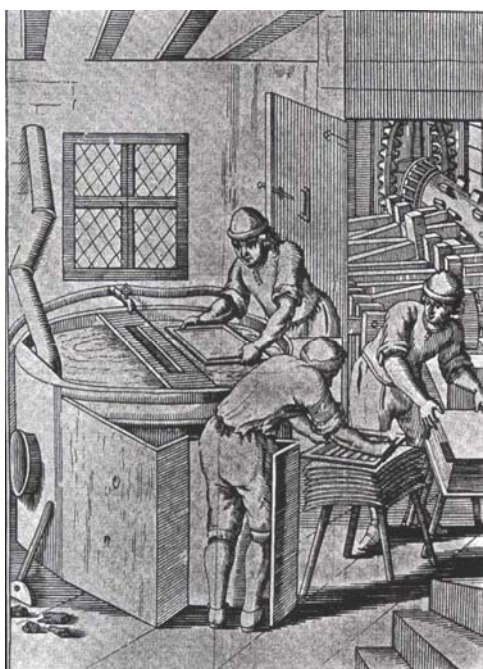
圖四：十七世紀歐洲的「抄」紙法，一人抄紙，另一人將抄好紙的網架反壓在毛布上，使濕紙轉移到布上。下一步將布與紙一同壓去水分，再將紙與毛布分開，吊在繩上自然乾燥。
