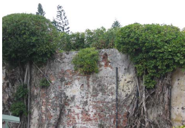
熱蘭遮城外城南壁殘跡，城牆以三合土砌成，高約三丈。維基百科提供。
